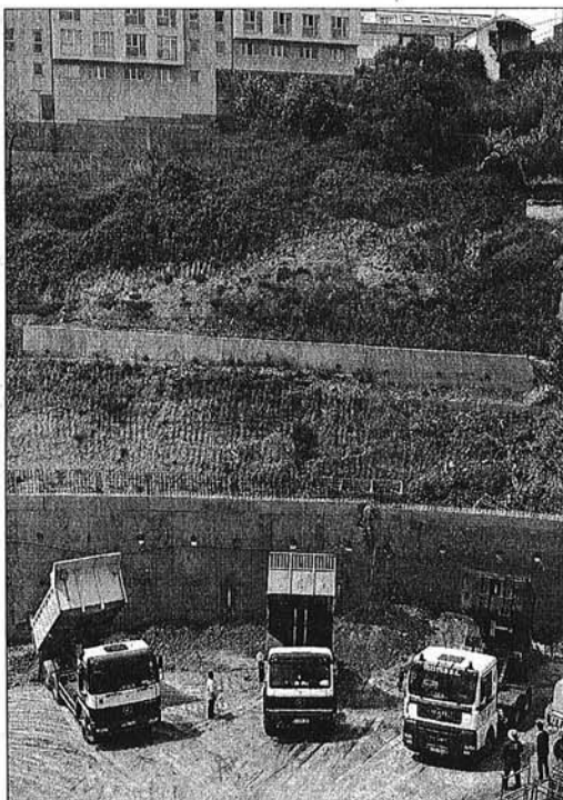
Obras de excavación en un solar de Sada. / FRAN MARTÍNEZ
